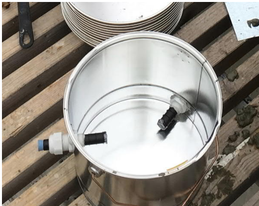
Bild 1. Montering av mätrör i betong. Förskruvningar har tätats på in och utsida med tätmassa.
